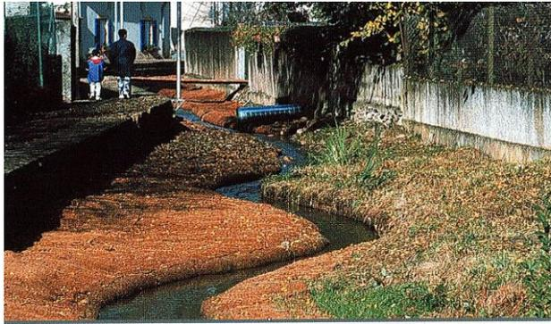
Ces travaux sont particulièrement lorsque le cours d'eau est rectiligne, relativement large et que l'écoulement se fait par conséquent de façon homogène. En période d'étiage on assiste régulièrement à un étalement de la lame d'eau sur certains secteurs de l'Issole, à l'origine d'une perte de la capacité d'accueil. La recréation d'un lit mineur bien définie permet de concentrer le flux à l'étiage et ainsi d'augmenter l'épaisseur de la lame d'eau.
