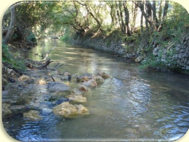
*Pose de petits blocs rocheux visant à créer des zones de courants et diversifier le milieu aquatique*
